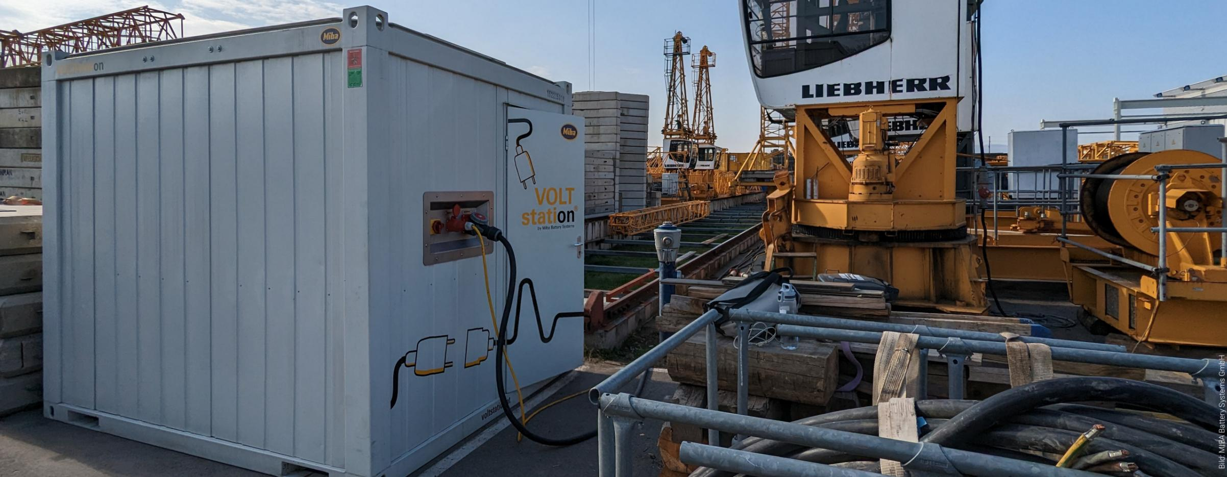
MIBA Battery Systems entwickelte für das Projekt „maxE“ einen Pufferspeicher-Container für den Betrieb von Baukränen.
